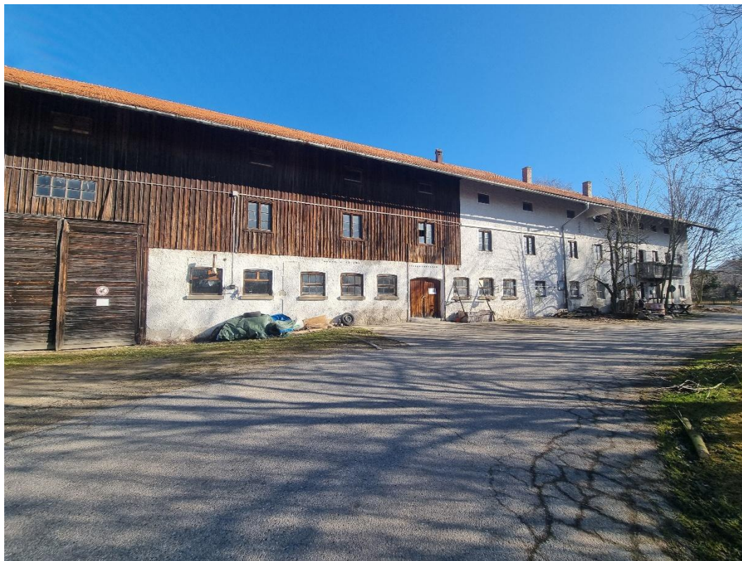
Abbildung 2: Südseite des Hofes (Wohngebäude rechts, Scheune/Heulager links) mit Gehölzen und versiegelter Einfahrt (Blickrichtung Norden).
