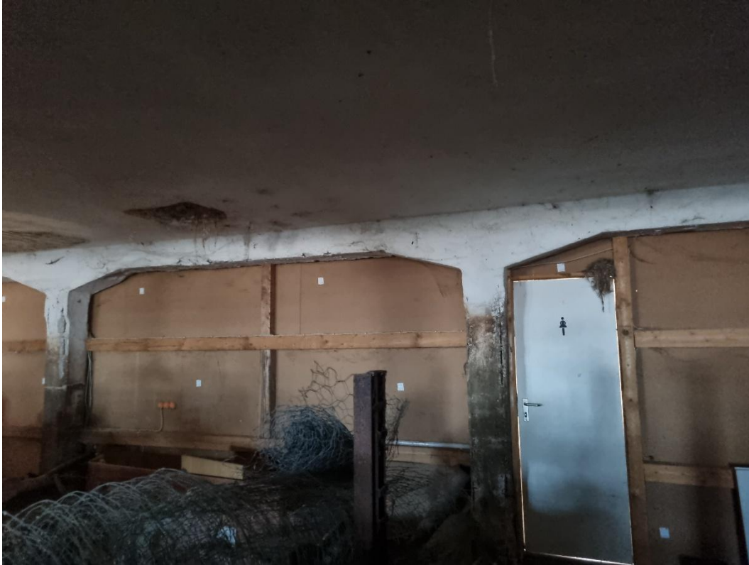
Abbildung 8: Zerfallenes Vogelnest im UG der Scheune.
