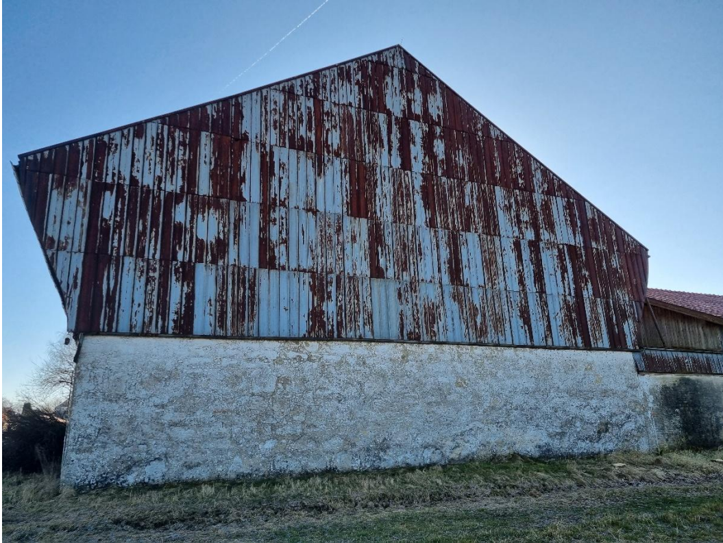
Abbildung 6: Westfassade des Gebäudes mit Blechverkleidung (Blickrichtung Osten).
