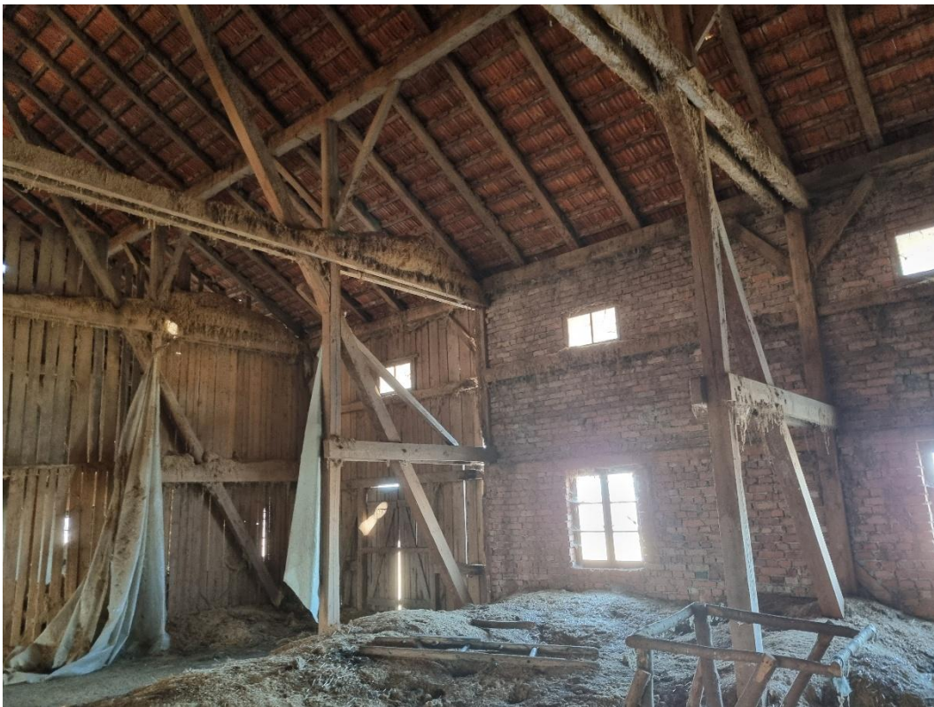
Abbildung 9: Einblick in das Heulager im OG mit offenen Holzbalken, Ziegelgemäuer und Heu am Boden.
