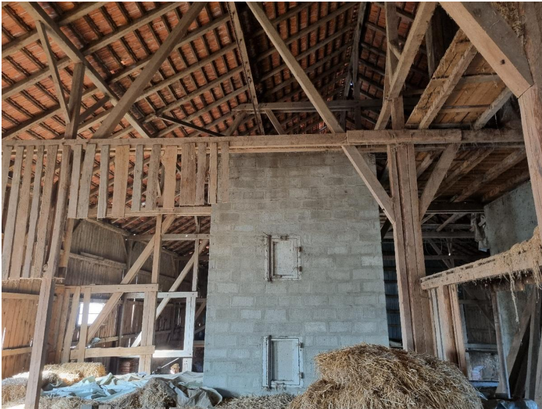
Abbildung 10: Einblick in das Heulager (Blickrichtung Westen).
