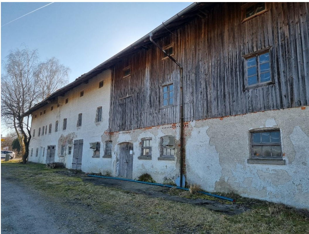
Abbildung 5: Nordfassade mit Holzverkleidung des Hofes (Blickrichtung Südosten).
